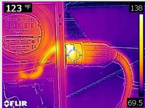
FLIR Thermal Image
